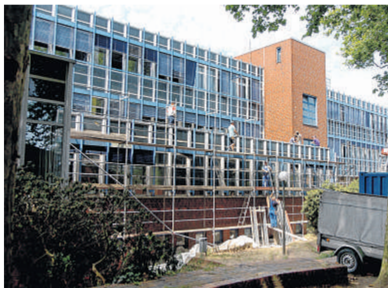
Die Sanierung der Fassade der Gesamtschule ist längst nicht abgeschlossen.
